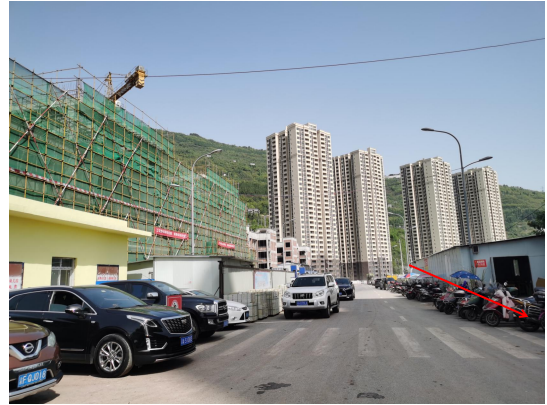
沿规划道路建设，目前已硬化
