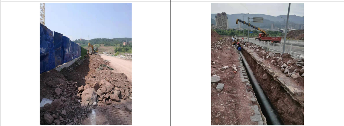
管网施工现场照片
