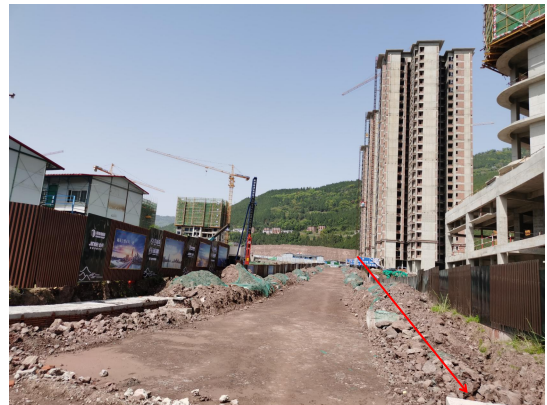
管道已进行敷设，规划道路仍在修建中，待道路建成后将进行硬化及覆绿
