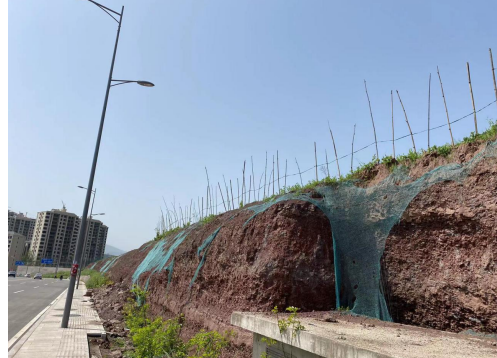
二期规划建设加压泵房等设施位置现状
