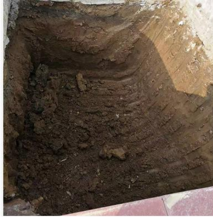
施工期简易隔油沉淀池
