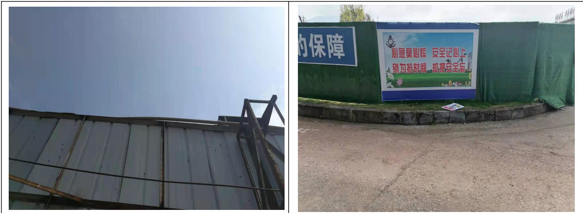
围挡封闭施工
