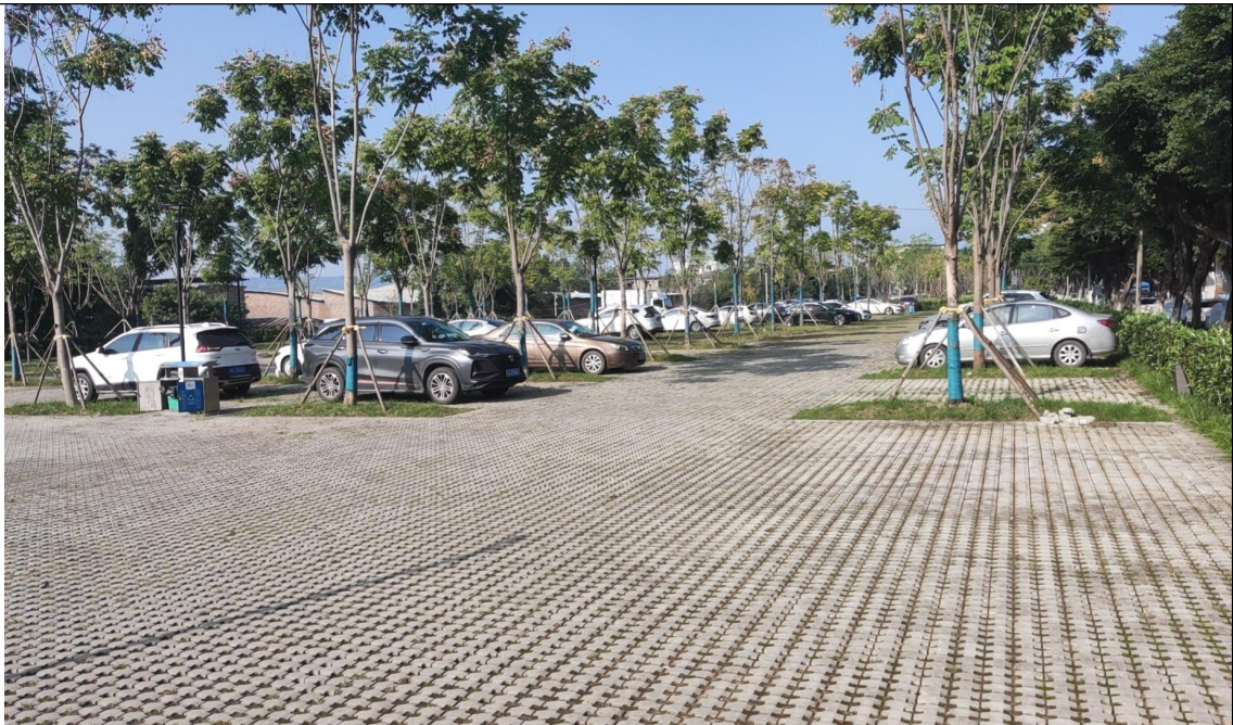
图 4-10 生态停车场（临时干化池拆除建设地点）
